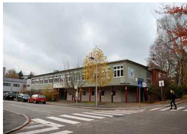
Umbau, Aufstockung und Energiesanierung werden auf der konstruktiven Grundlage vorgefertigter Fassadenelemente in Holzleichtbauweise durchgeführt.
